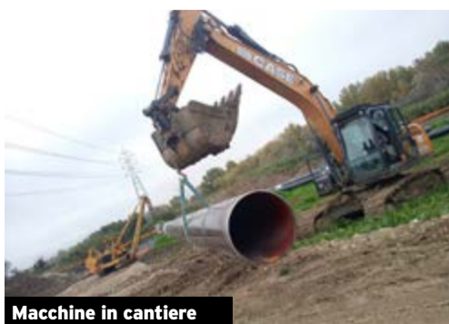
Macchine in cantiere
