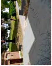
1) Punto di confluenza v. Amadeo - Saffi-Caracci La rampa attuale con p=5% e senza ripiani di appoggio
