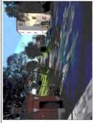
1) Punto di confluenza v. Amadeo - Saffi-Caracci La rampa attuale con p=5% e senza ripiani di appoggio
