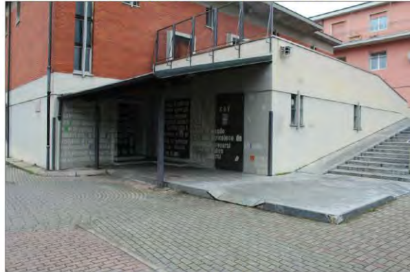
VISTA SUD DELL'EDIFICIO DI CULTO
