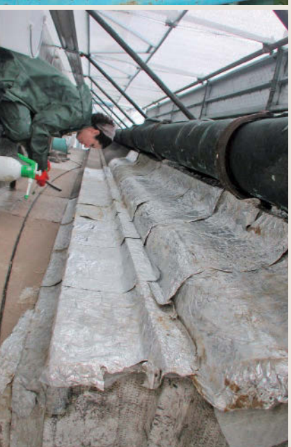
2-3. Impacchi a base di cloruro di benzalconio: sono stati applicati in corrispondenza degli attacchi biologici. Successivamente alla rimozione degli impacchi è stato eseguito un lavaggio con acqua distillata e spazzolatura per favorire la dissoluzione di croste nere e asportare i residui di solvente.
