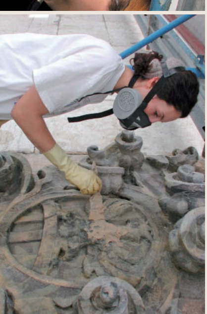
4-5. La scelta di ricorrere alla tecnica laser è stata dettata dalla presenza di incrostazioni tenaci su di una superficie lapidea che si presentava sollevata a grandi scaglie; in questi casi, infatti, un'eventuale azione meccanica avrebbe provocato l'irrimediabile perdita di frammenti lapidei.
