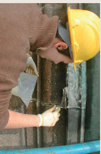
2-3. Impacchi a base di cloruro di benzalconio: sono stati applicati in corrispondenza degli attacchi biologici. Successivamente alla rimozione degli impacchi è stato eseguito un lavaggio con acqua distillata e spazzolatura per favorire la dissoluzione di croste nere e asportare i residui di solvente.
