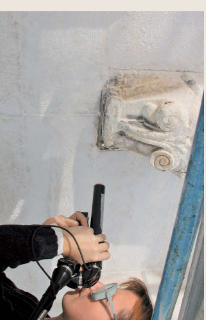
4-5. La scelta di ricorrere alla tecnica laser è stata dettata dalla presenza di incrostazioni tenaci su di una superficie lapidea che si presentava sollevata a grandi scaglie; in questi casi, infatti, un'eventuale azione meccanica avrebbe provocato l'irrimediabile perdita di frammenti lapidei.
