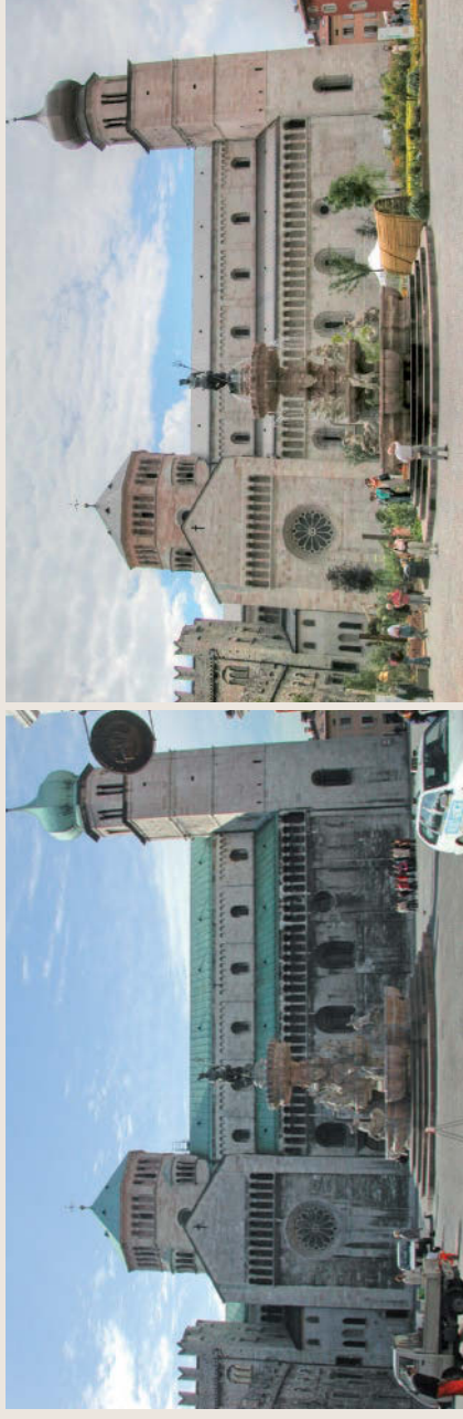
6-7. Prima e dopo. Le superfici dei prospetti esterni sono state sottoposte, nel corso del tempo, a numerosi interventi di restauro, non sempre sufficientemente documentati; alcuni hanno portato alla sostituzione di conci di pietra, altri all'applicazione sulle superfici di prodotti a base organica con finalità di protezione, restauro e manutenzione.
